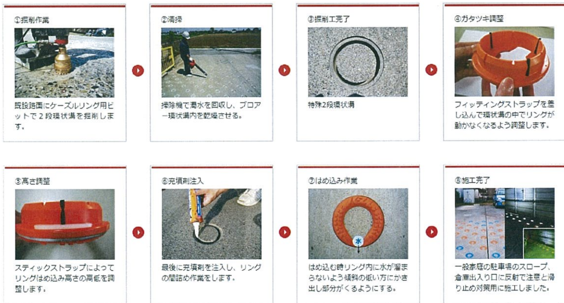
図-1 ケーズル工法の施工フロー
